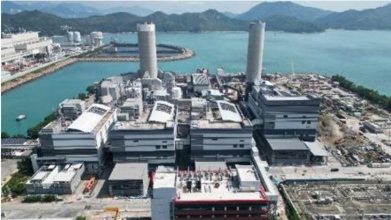
南丫發電廠現有 4 台燃氣聯合循環發電機組，包括在 2006 年啟用的 L9 機組以及在「2019 - 2023 年發展計劃」內分別興建的 L10、L11 和 L12 機組。
